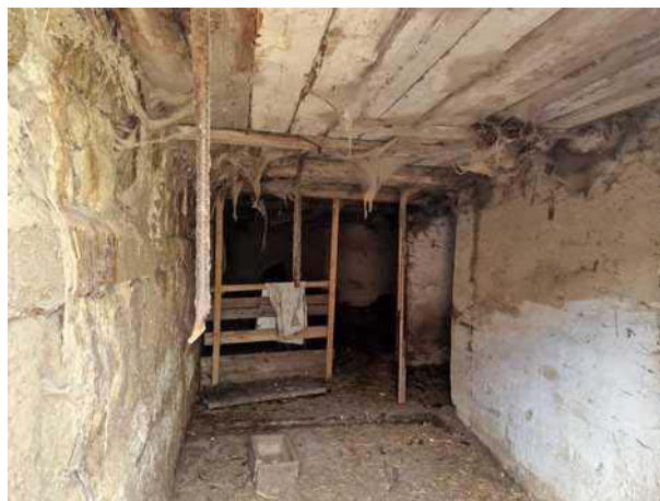
vnitřní prostor hospodářská budova - chlév
