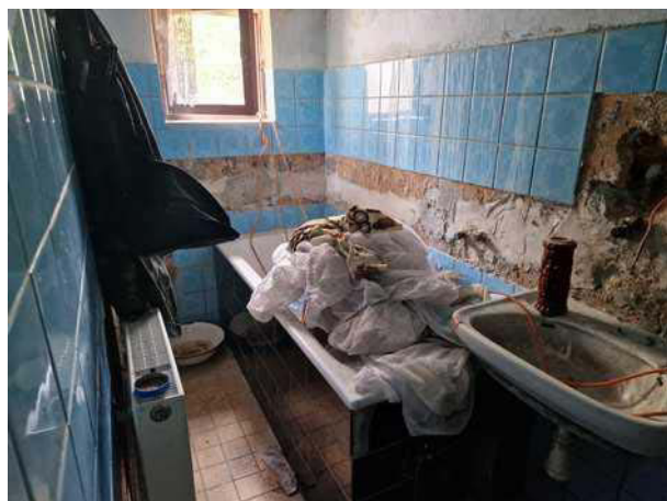
1. NP - koupelna (zahájeny stavební úpravy)
