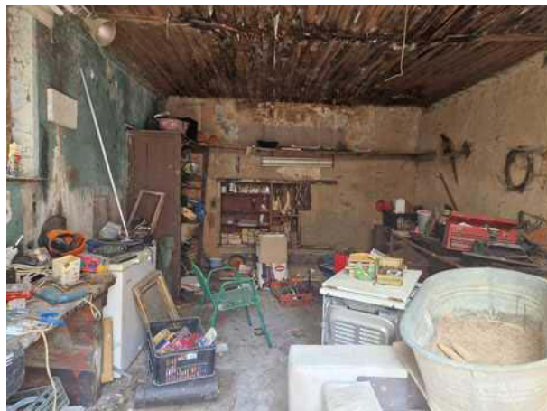
vnitřní prostor hospodářská budova – garáž se skladem
