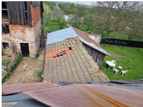
pohled kolna střecha
