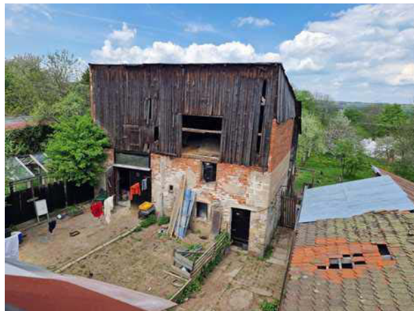
pohled přední hospodářská budova
